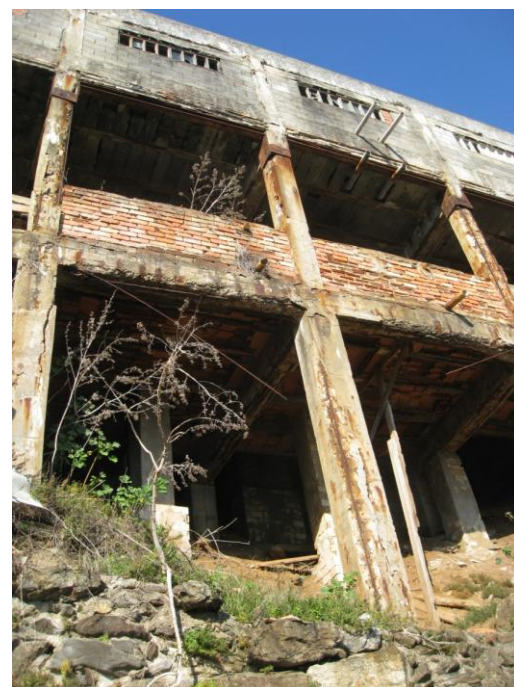
Estado precario de la estructura a demoler (Parcela 6)
